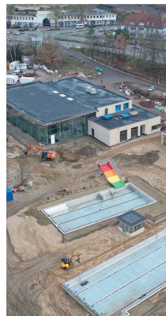
Die Landschaftsbauarbeiten laufen zum Jahresende 2021 auf Hochtouren.
