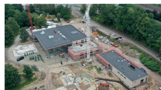
Die Dachflächen sind geschlossen und die Schornsteine an ihrem Platz.
