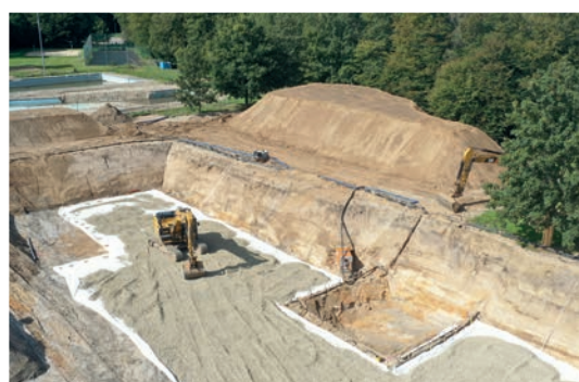
Mit der Baugrube startet das Vorhaben.
