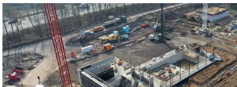
Aus 175 Bohrpfehlen entsteht das Fundament des Eingangs- und Umkleibereiches.
